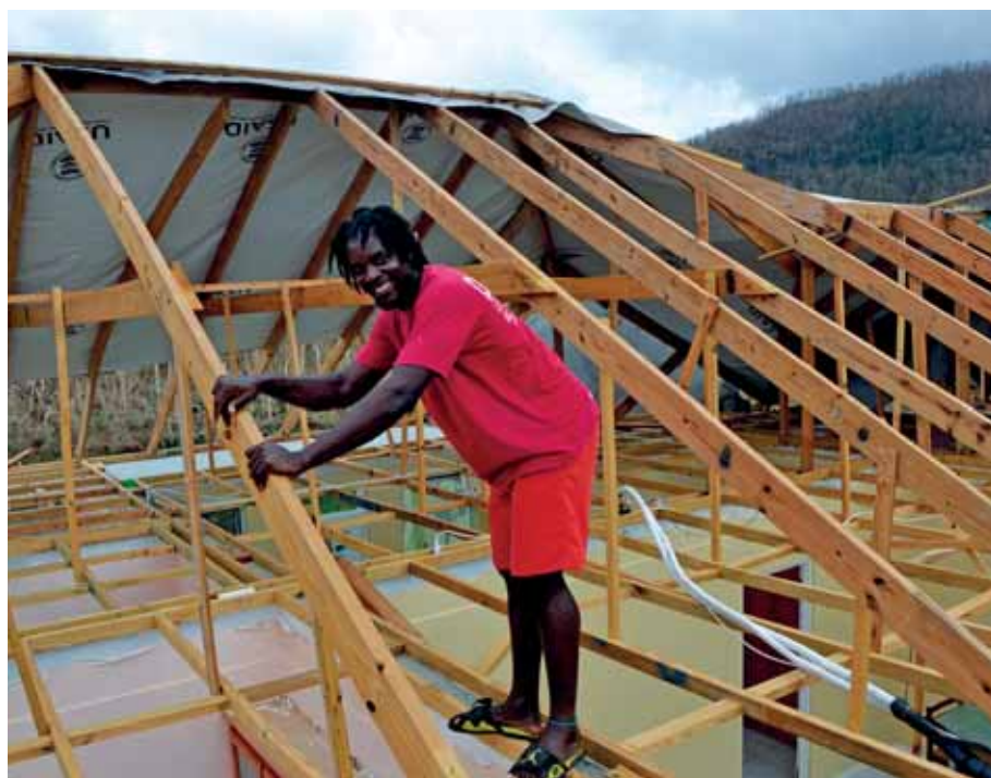
Devon na střeše
